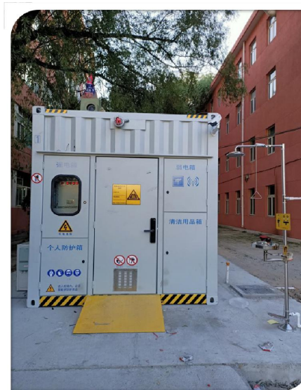
实验废弃物暂存中转站
